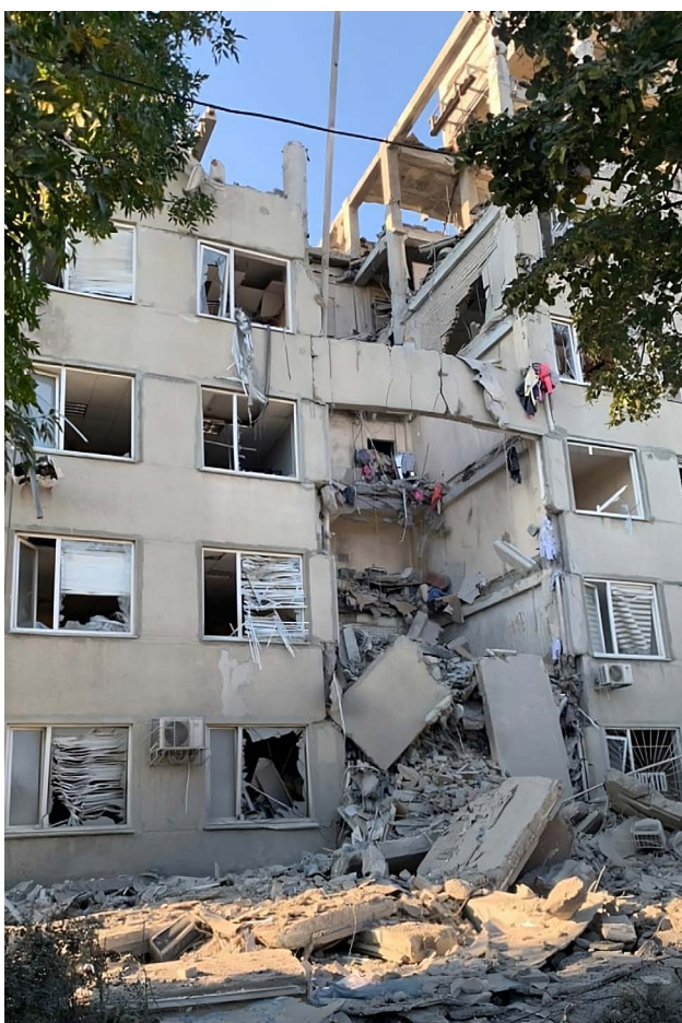
На фото зруйнована російською ракетою будівля, в якій розміщене приміщення ММБФ «ЮНІТУС», 2022
